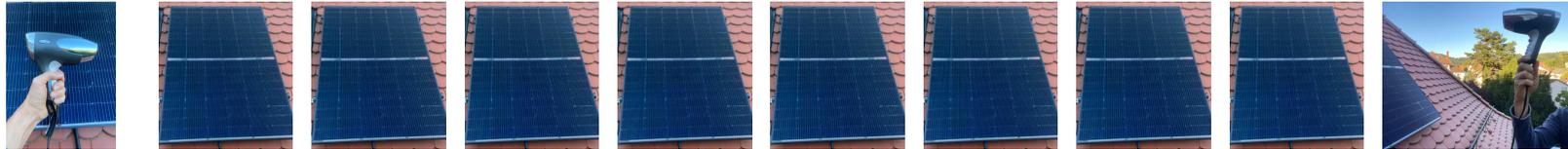
Mein Balkonsolarmodul (1,15m x 1,75m, 360 W) mit Südausrichtung hat an einem sonnigen Tag (7. August 2025) 1,8 kWh erzeugt, das war im Tagesdurchschnitt 75 W. Im Jahresdurchschnitt liefert es knapp 50 W.
