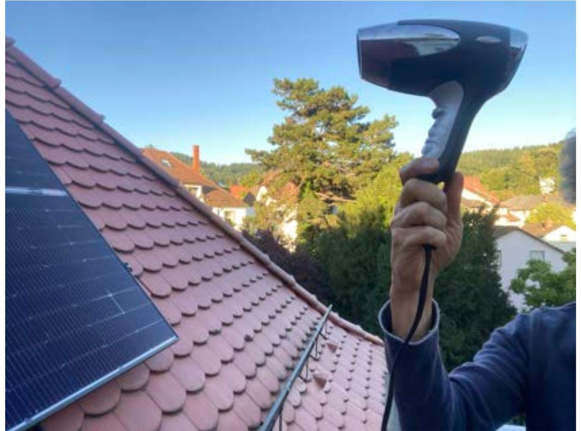
Mein Balkonsolarmodul (1,15m x 1,75m, 360 W) mit Südausrichtung hat an einem sonnigen Tag (7. August 2025) 1,8 kWh erzeugt, das war im Tagesdurchschnitt 75 W. Im Jahresdurchschnitt liefert es knapp 50 W.
