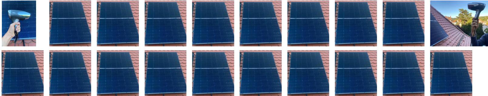
Mein Balkonsolarmodul (1,15m x 1,75m, 360 W) mit Südausrichtung hat an einem sonnigen Tag (7. August 2025) 1,8 kWh erzeugt, das war im Tagesdurchschnitt 75 W. Im Jahresdurchschnitt liefert es knapp 50 W.
